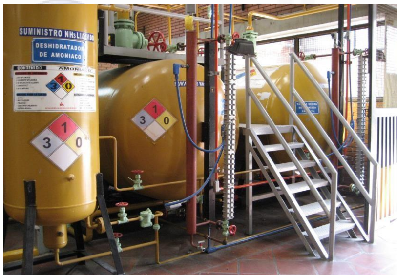
Montaje de Sondeas de nivel para tanques de amoniaco, Adecuación de Tuberías.
