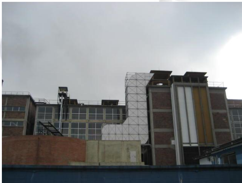
Fabricación y montaje de chimenea en acero inoxidable para tostador maltería de tibito
